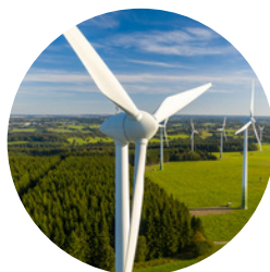
Wind Energy Turbines 風力發電應用
